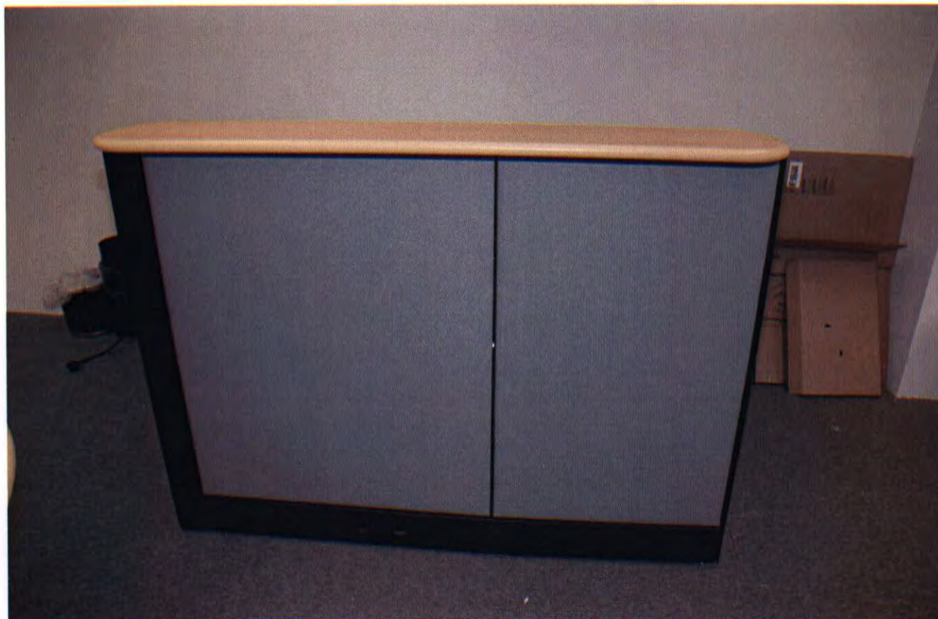
A estação da recepcionista está com painéis em tamanhos diferentes, em desacordo com o projeto executivo.
