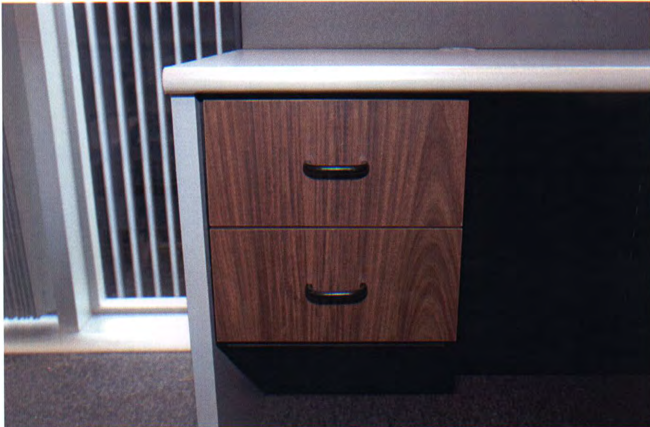
Falta fechadura nos gaveteiros das estações e postos de trabalho de assessores.
