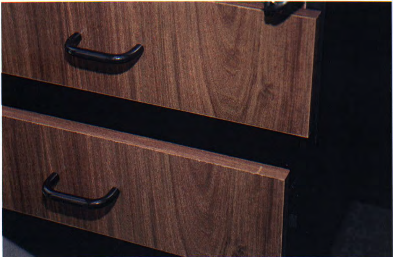
O laminado está com corte e aplicação grosseiros, dando acabamento esbeijado.
